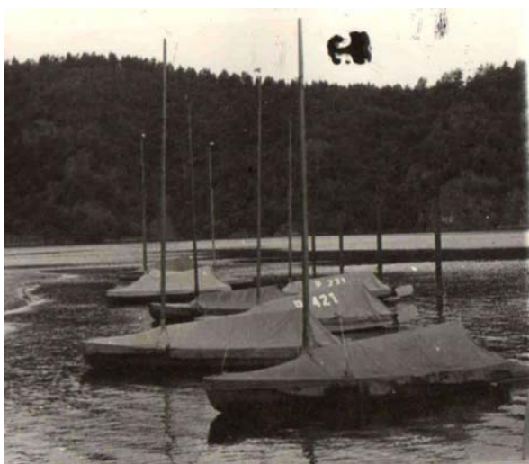
Provizorní kotvení po dobu stavby (rok 1969)
