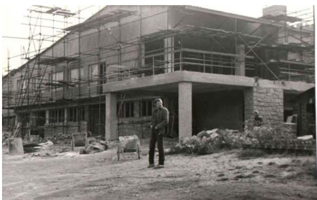
Hrubá stavba (v popředí Jiří Drtina)
